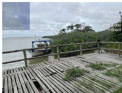
Figura 4 – Estrutura existente do deck de madeira e do corrimão
