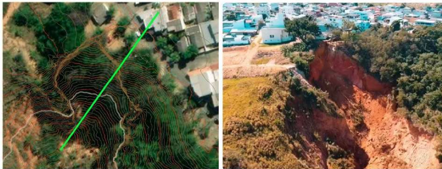
Figura 4 – Região crítica Avenida Pedra Azul que ocorreu a movimentação de solo – Colatina/ES
