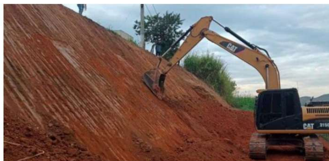
Figura 5 – Exemplo de limpeza, movimentação de terra e retaludamento a ser implantado em trechos da região de Vista da Serra – Colatina/ES
